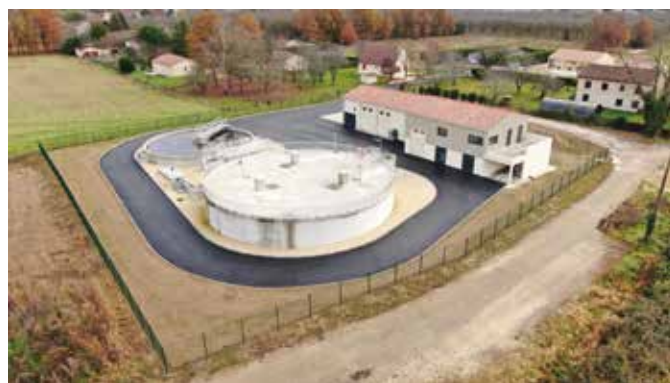
Inauguration de la station d'épuration du Bugue le 07.10.2022
